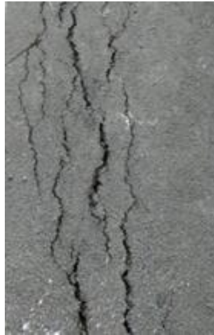
Fig.1.2 Longitudinal crack
